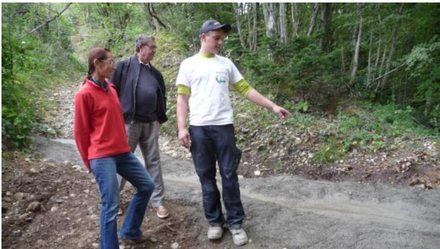
Sur le chemin rural situé au-dessus du hameau de la Mérie, deux renvois d'eau ou cunettes ont été réalisés en béton ferraillé en travers du chemin pour canaliser et dévier les eaux d'orage qui descendent en dévalant le versant avec terre et galets jusqu'à la voirie du hameau.
