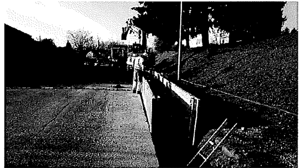
Tranchée ouverte avec protection par des blindages – rue René Payot
