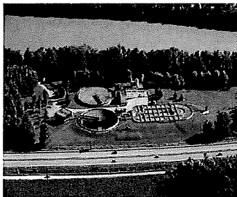
Vue sur la station existante
