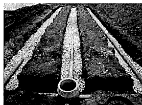
Réalisation de tranchées d'épandage
