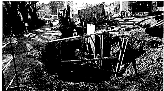
Pose de conduites – rue des Hortensias
