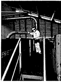
Gestion du chargement des bennes à boues
