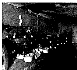
Intérieur d'un nouveau regard comprenant un stabilisateur de pression
