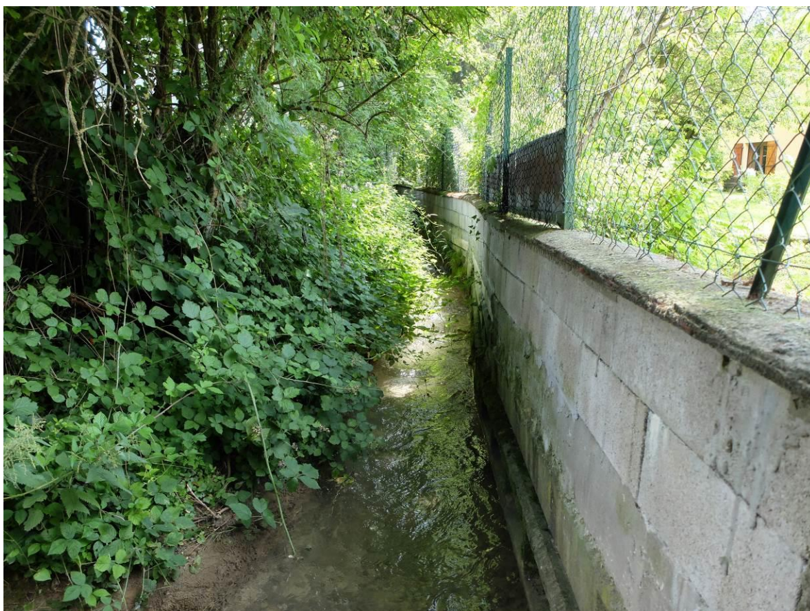
Le Crozariou en amont du pont : lit étroit
